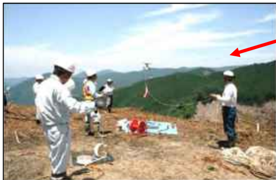
架線設置のためのドローンによるリードロープ運搬
