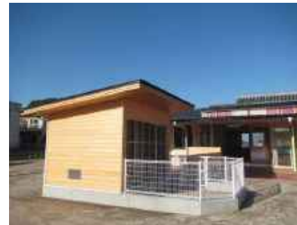
幼稚園 屋根 (観音寺市)
