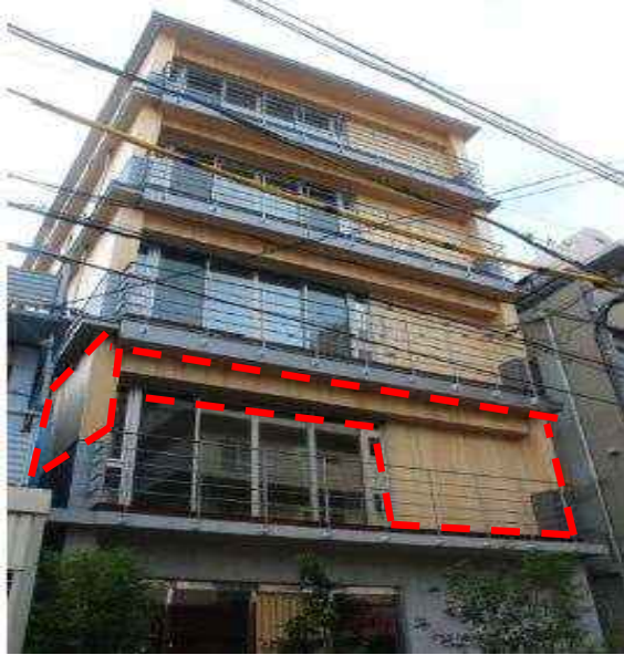
RC造(1F)との混構造による5階建て
