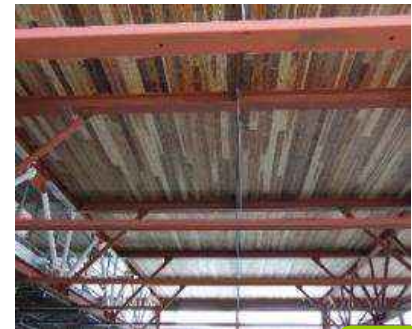
スーパーマーケット天井 (観音寺市)
