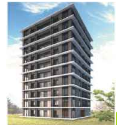
CLT・木質耐火部材を活用した10階建てマンション(宮城県仙台市)
