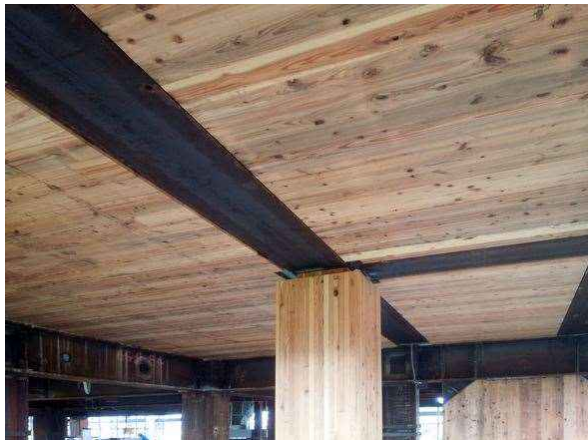
CLT床材を下から見た様子(資料:三菱地所)
