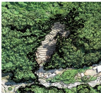
■徳島県上勝町の被災現場のオルソ画像(H30年7月)
