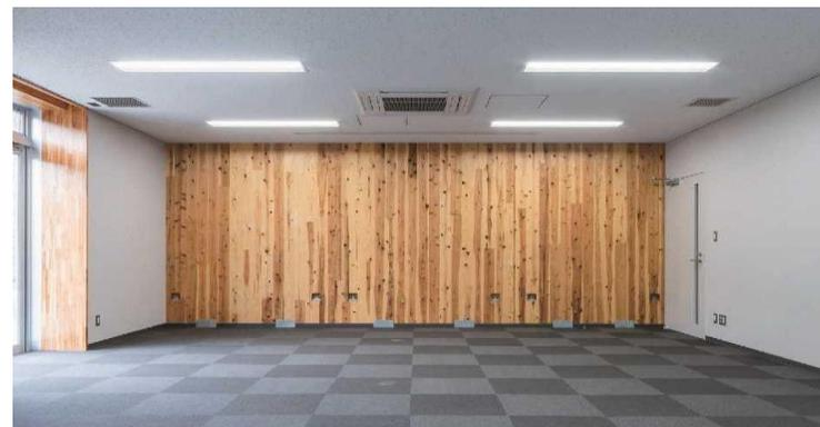
※CLTとは、直交集成材の(Cross Laminated Timber)略で、ひき板(ラミナ)を繊維方向が直交するよう積層接着した重厚なパネル
