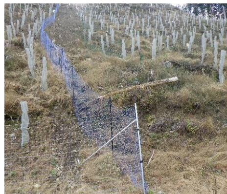
地形に応じた高さの 防護ネット設置
