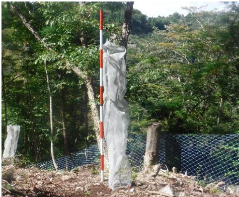
耐久性を考慮した 単木保護資材の設置
