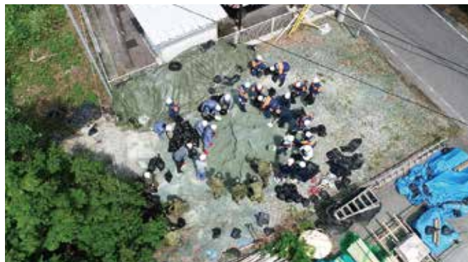
ドローンで撮影した土のう作り訓練状況
