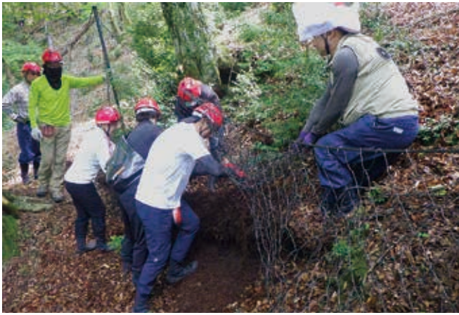
大量の落ち葉や土砂で埋まったネットの掘り出し
