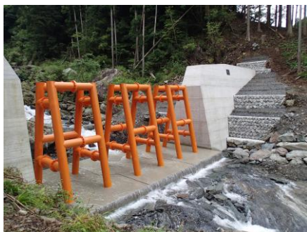
鋼製スリット谷止工
