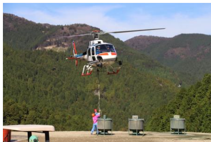
航空実播工実施状況
