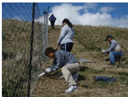
シカの食害からササ原をまもる柵を設置
