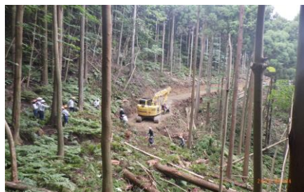
作業道作設の様子
