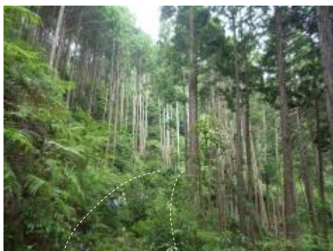
平成20年に作設された森林作業道の現在の状況 適度な光環境により下草(シダ等)に覆われている (一部で表面水の流出が見られるが林地荒廃はしていない)
