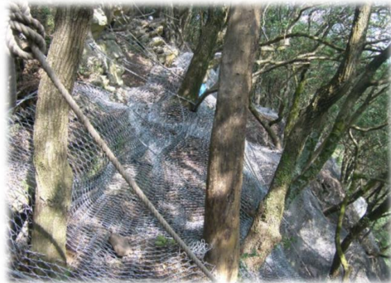
落石防止工 (高松市 屋島国有林)
