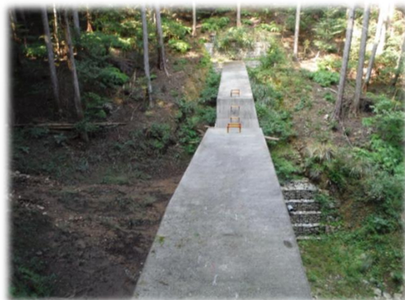
緩和された溪床勾配（堰堤の上流側（写真左側）に土砂を堆積させ谷の勾配を緩和）
