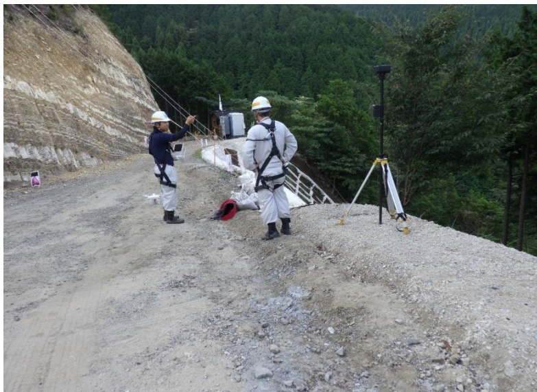
出来形計測の様子
