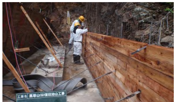
谷止工の木製枠組立状況
