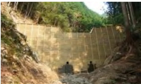
木製型枠を使用した谷止工
