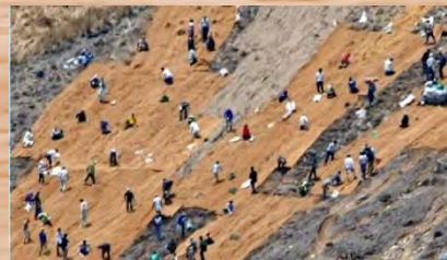
ボランティアとの共同による土砂流出防止のためのマット敷設（高知県香美市）
