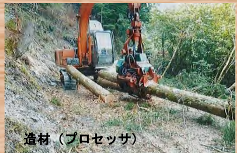
森林作業道開設
