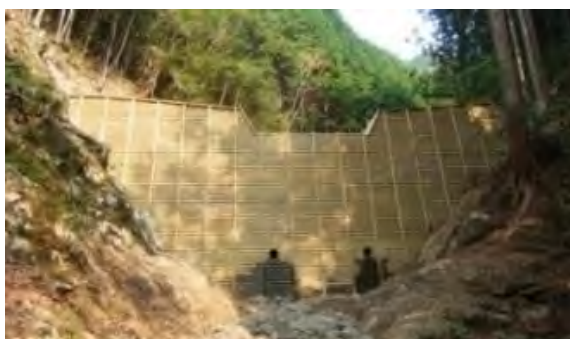
木製型枠を使用した谷止工
