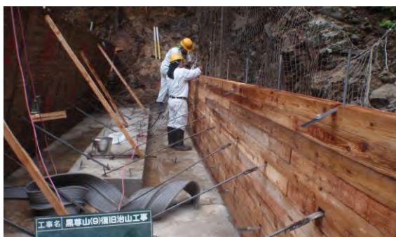
谷止工の木製枠組立状況
