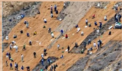
ボランティアとの共同による土砂流出防止のためのマット敷設（高知県香美市）
