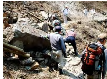
遊歩道の整備
