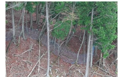
(写真2：支柱の代わりに立木を利用した ネットの施工箇所)
