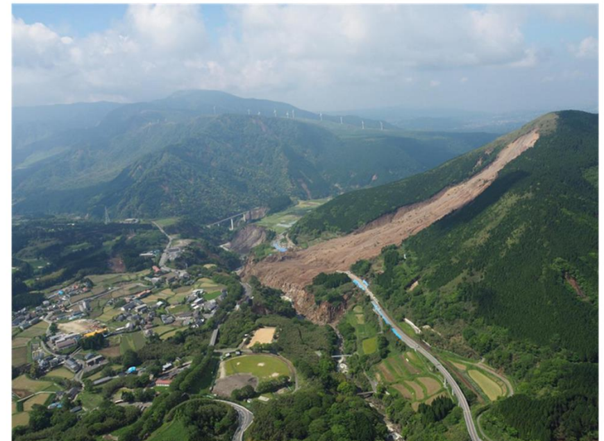
熊本地震による斜面崩壊 出典：国土交通省九州地方整備局
