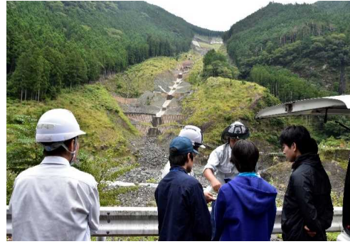
崩壊地の状況確認
