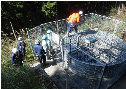
集水井の現地確認
