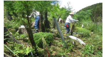
修復作業中（矢筈谷山）
