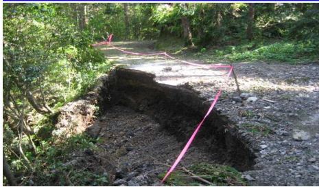
県道325号（路肩決壊）
