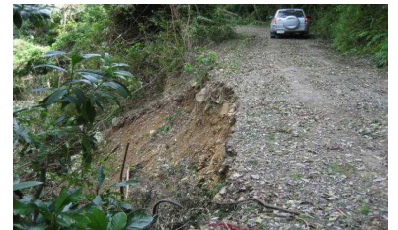
橋ヶ谷林道（路肩決壊①）
