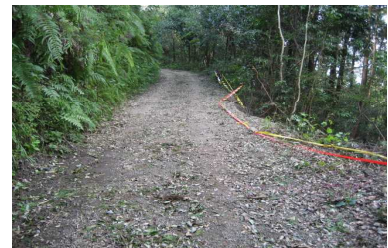
橋ヶ谷林道（路肩決壊②）
