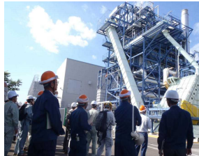
木質バイオマス発電施設
