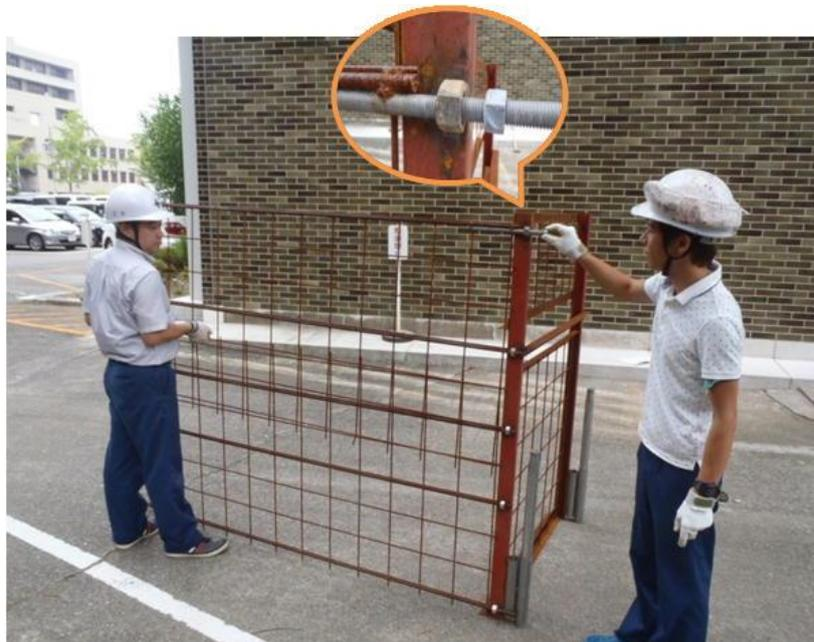
(エ) 両側の側面枠を設置した後、後方枠を差し込む。このとき、後方枠に溶接している穴に側面枠(上下)のすべての鉄筋を差し込み、最上部のボルトをナットで仮締めする。
