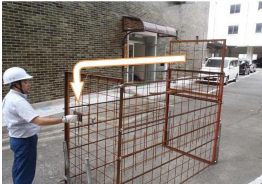
(10) 後方枠側では、ワイヤーAを写真のように通して先端の輪をパイプに引っかける。
