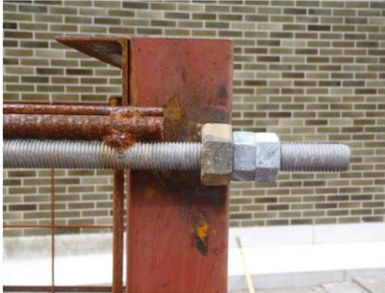
(カ) 後方枠に足場クランプを取り付けたあと、固定杭を軽く打ち、固定杭に足場クランプを仮止めし、再度、固定杭を打ち込む。その後足場クランプを本締めする。
