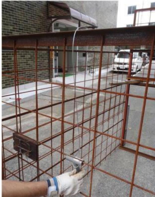
(11) 一人がゲート横のアンクルに引っかけていたゲート凸部と生き枝をゆっくりと外しながら、併せてワイヤーAのテンションを利かせながらゲートを下ろす。
