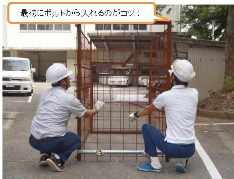
(オ) 全体のバランスを調整のうえ、(エ)で刈締めしていたゲート枠(入口)側も含め、最上部全4カ所を各2個のナットで完全に締める。
