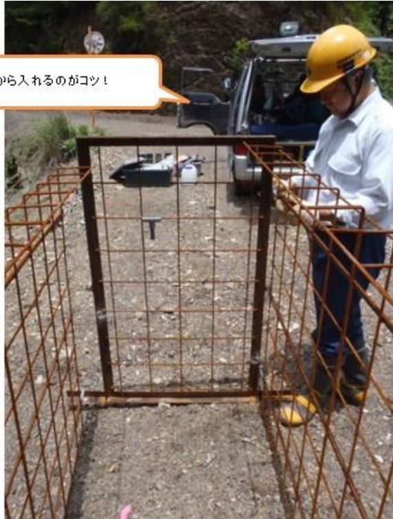
(エ) 全体のバランスを調整のうえ、(イ)で仮締めしていたゲート枠（入口）側も含め、最上部全4カ所を各2個のナットで完全に締める。
