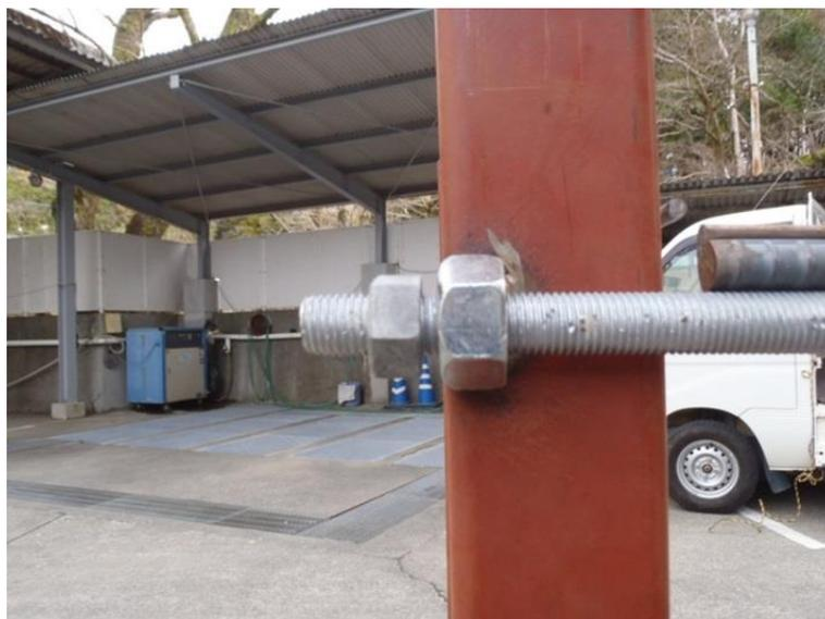
(ウ) 両側の側面枠を設置した後、後方枠を差し込む。このとき、後方枠に溶接している穴に側面枠のすべての鉄筋を差し込み、最上部のボルトをナット
