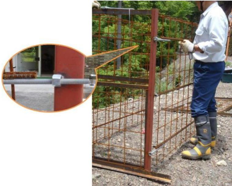
(イ) 次に、側面枠のボルト側が上になるようナットの穴に差し込み、最上部のボルトを付属ナット1個で仮締めをする（後の全体調整のためナットとナットの幅を1～2cm程度開けておく。）
