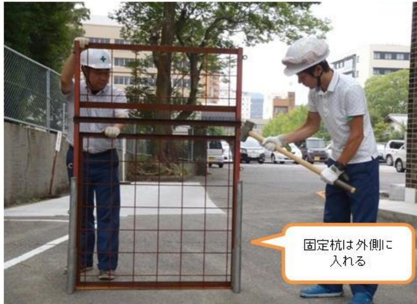
(イ) ゲート枠（開閉部）に溶接しているナットの穴に、側面枠（下用）の鉄筋をし込む。
