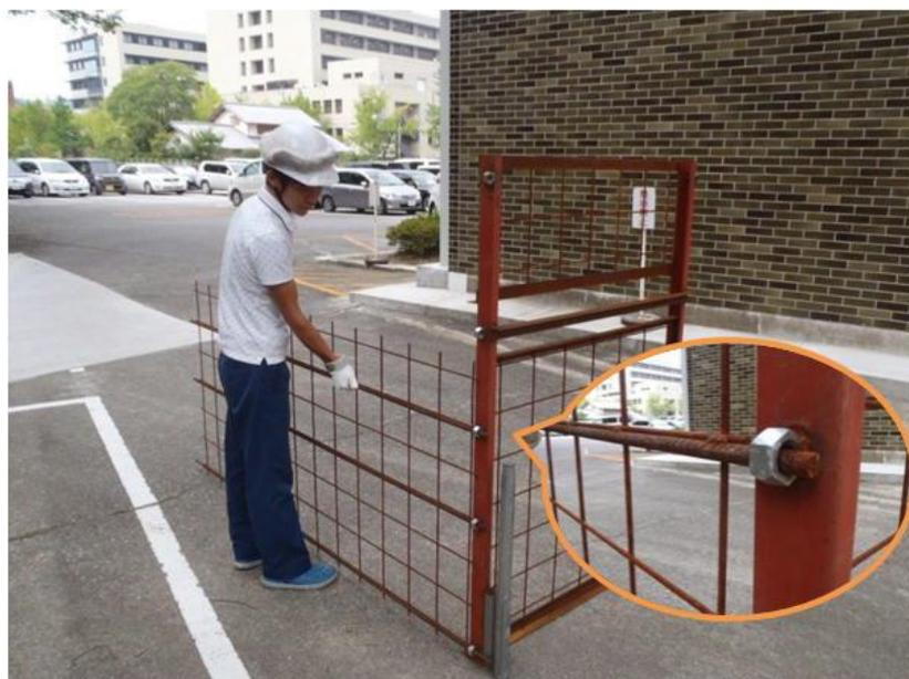
(ウ) 次に、側面枠（上用）のボルト側が上になるようナットの穴に差し込み、最上部のボルトを付属ナット 1 個で仮締めをする（後の全体調整の
