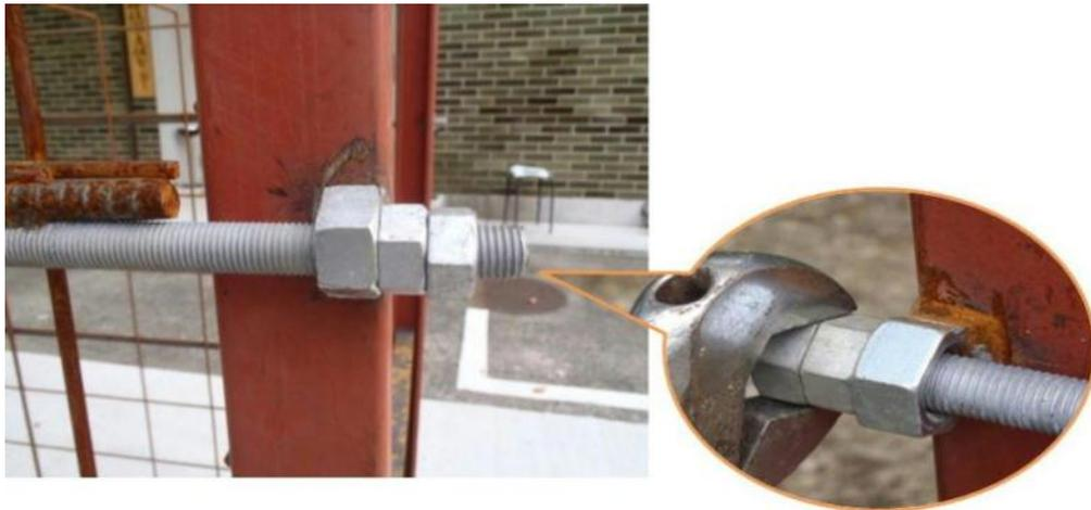
(オ) 後方枠に足場クランプを取り付けたあと、固定杭を軽く打ち、固定杭に足場クランプを仮止めし、再度、固定杭を打ち込む。その後足場クランプ
