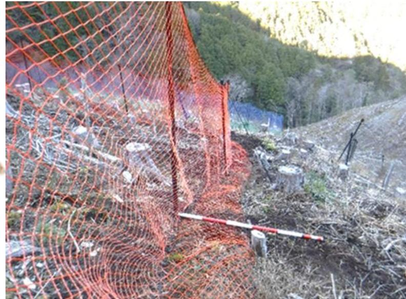
規格：全高2.4m 目合50mm 地際から1.0mの高さにステンレス線入り
