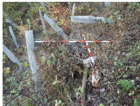
写真17 斜面に点在する枝条と隙間を確認（エリア1）
