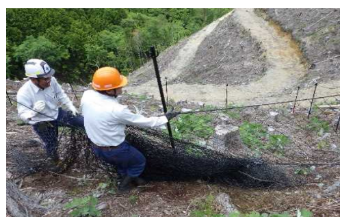
写真7 ネット引回し作業
