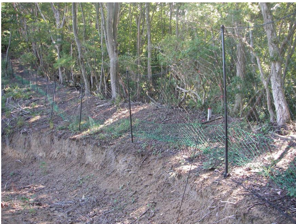
図 13. 防護ネットの設置状況（下福家山国有林）
