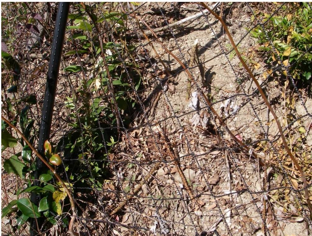
図 12. 防護ネットの設置状況（地蔵平山国有林）
