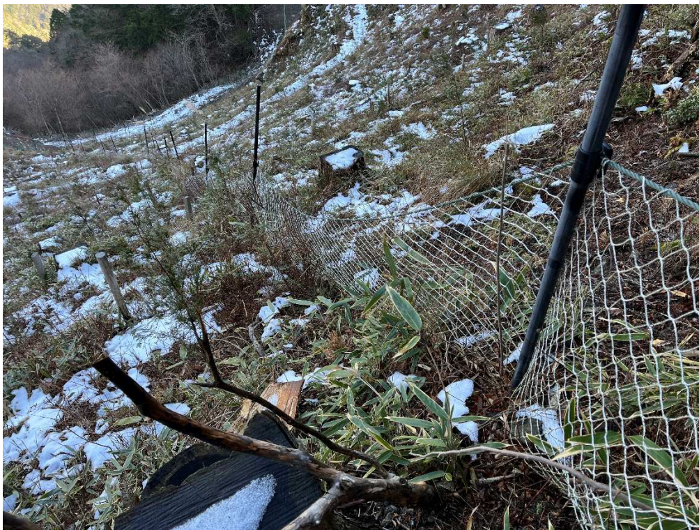
図 27. ノウサギ用防護ネットの設置状況（柚ノ木山国有林）
