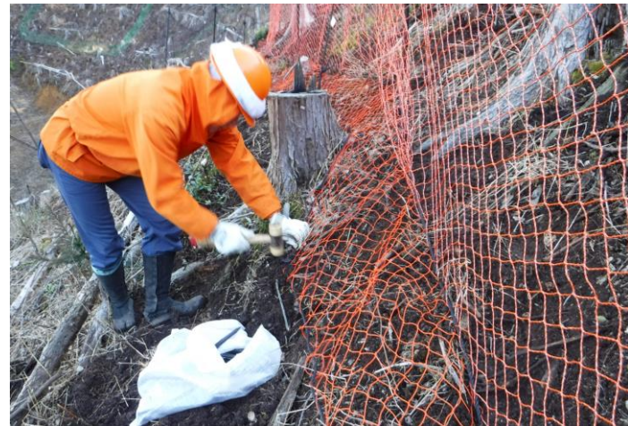
L字張りネットペグ打込
