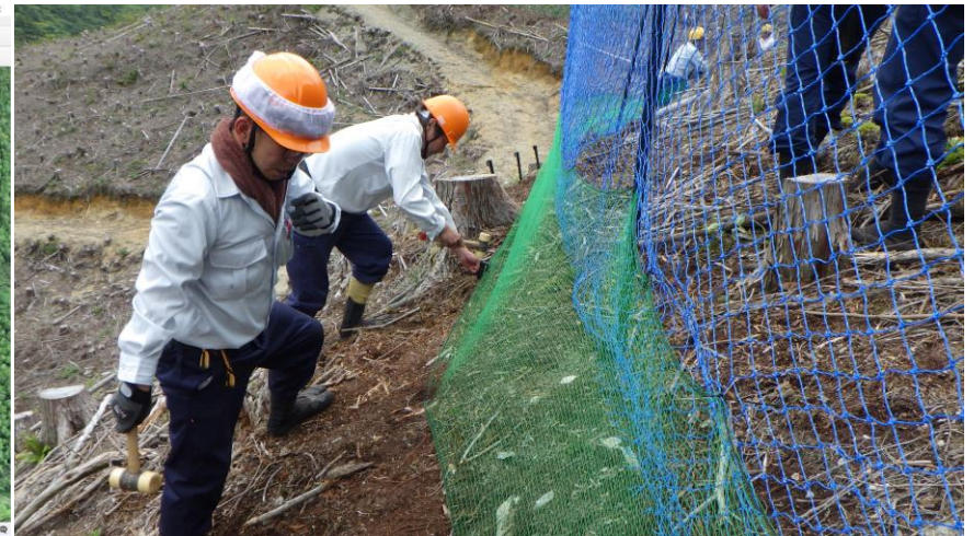
防護ネット設置作業
