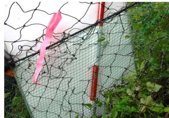
タイプB 本体ネットの破損
