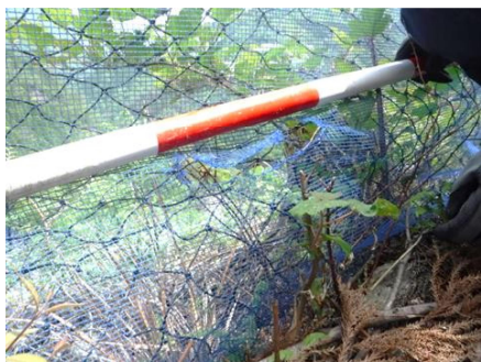
タイプA 防風用ネットの破損
