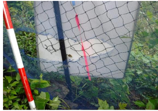
タイプA 本体と防風用ネットの破損
