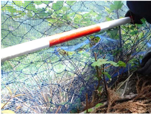
写真 12 タイプ A 防風ネットの破れ
