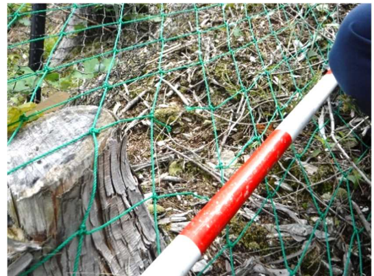
写真 13 タイプ D 従来型スカートネットの破れ
