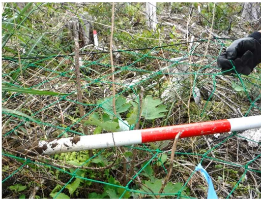
写真 14 タイプ D 従来型スカートネットの破れ
