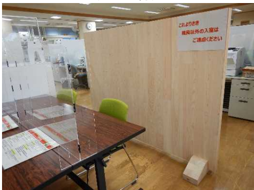
愛媛森林管理署事務室に設置したCLTパネル(ヒノキ材)
