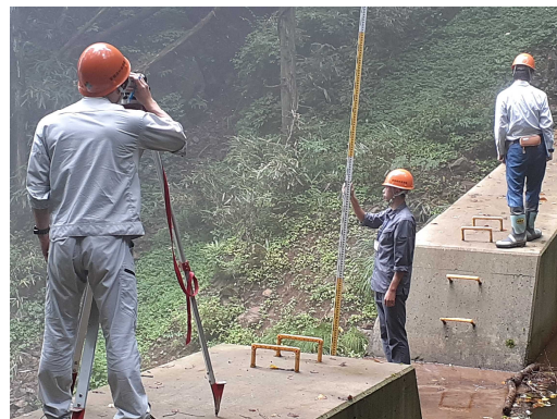
治山工事の検査実習
