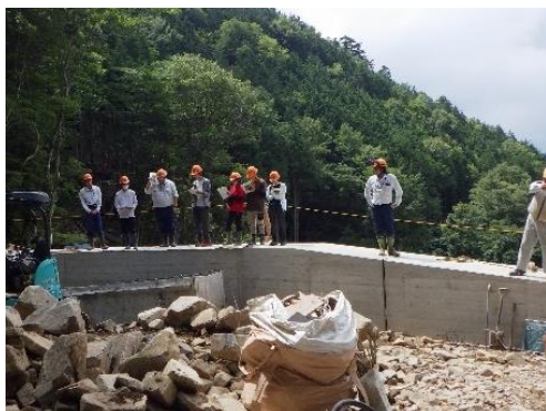
愛媛大学インターンシップ（治山現場実習）
