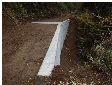
林道改良（災害復旧）
