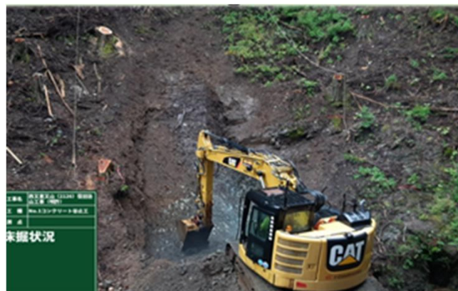
MGバックホウによる施工
