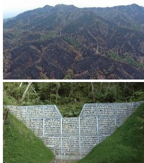
林野火災跡地と谷止工
