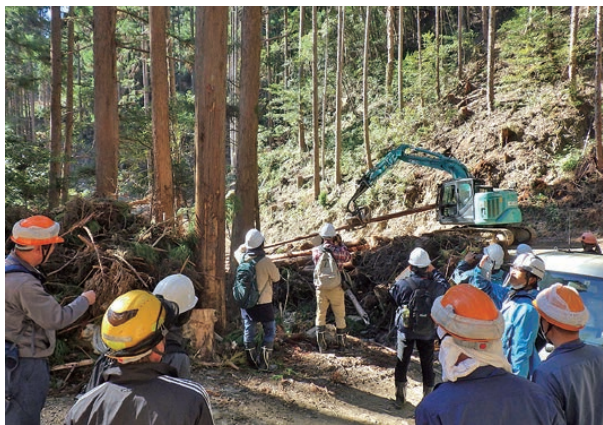
プロセッサ（※写真奥青色の機械）による造材を見学
