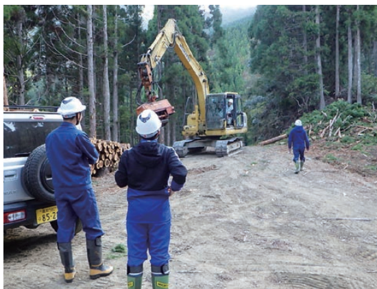
架線集材の見学
