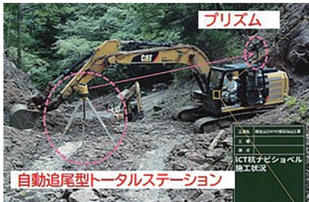
ICT施工の様子
