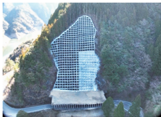
復旧治山工事
