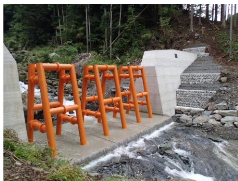
吉野川上流地区仁尾ヶ内（上） 復旧治山工事
