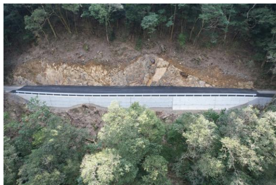
奥藤林道改良工事
