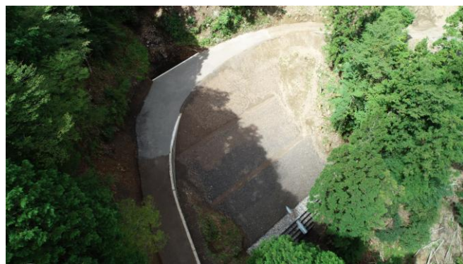
西又東又林道災害復旧工事
