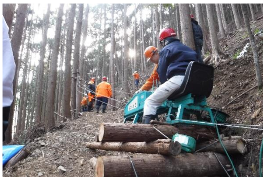
電動集材機操作の様子
