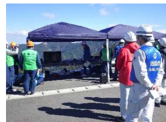
演習の様子(モニターによる確認)
