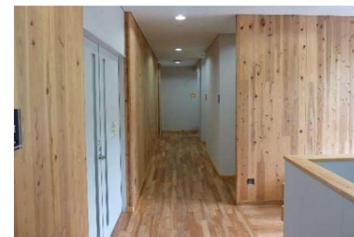
CLT内壁と床サクラ材(2階)
