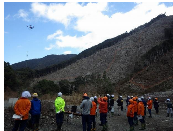
ドローンを活用した資材運搬
