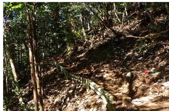
千本山遊歩道整備 (令和3年3月整備後)
