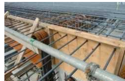
国産材コンクリート型枠用合板 (北陸新幹線工事)
