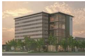
建設会社新社屋【佐賀県】
