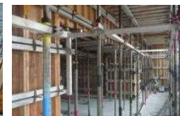
実証施工の様子
