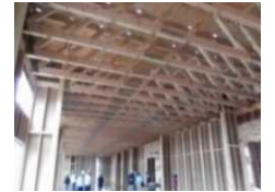
製材による大規模トラス
