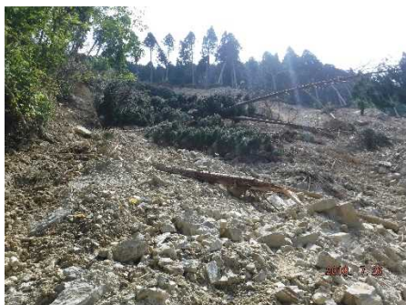
三好市山城町根津木地区の災害現場
