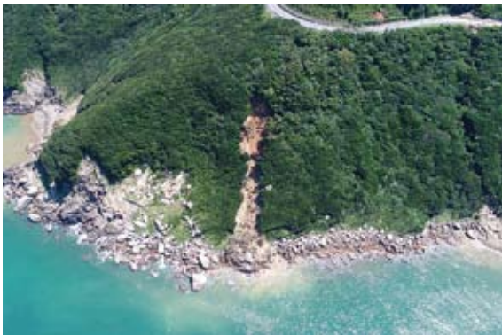
災害発生時の崩壊の様子
