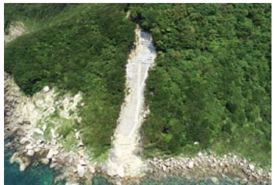
工事完成時の復旧の様子
