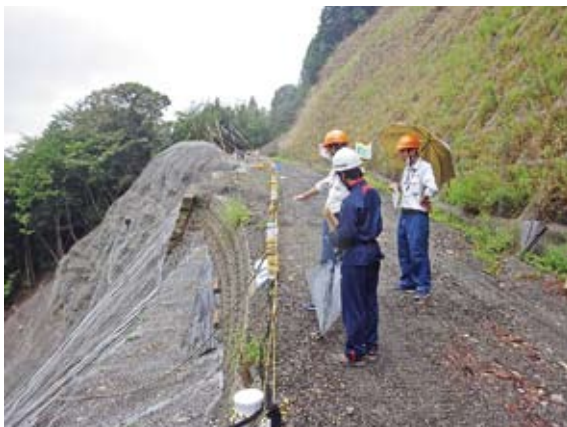
治山事業山腹工法について説明を受けている様子
