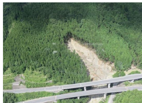
大豊町立川上名の被災現場
