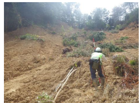
測量作業の様子
