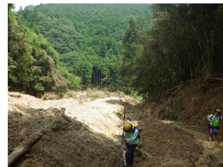
測量作業の様子
