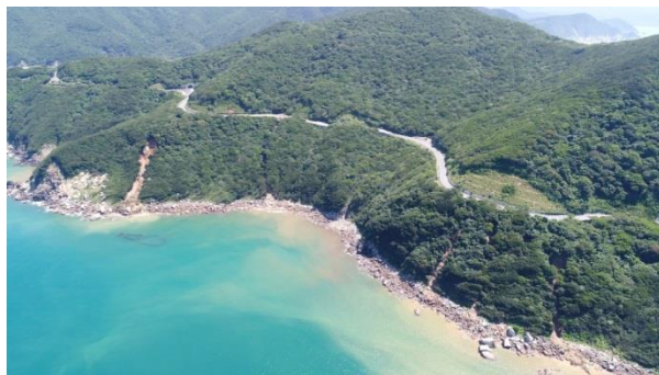
高知県大月町の被災現場のドローンの空撮画像
