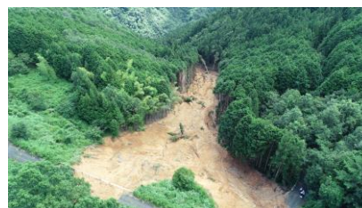
大洲市河辺町の被災現場
