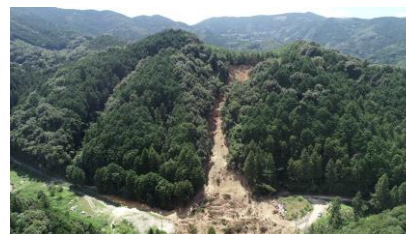
大洲市平野町の被災現場①
