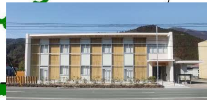
国の施設で初のCLTによる庁舎 (H30.12月新庁舎完成)
