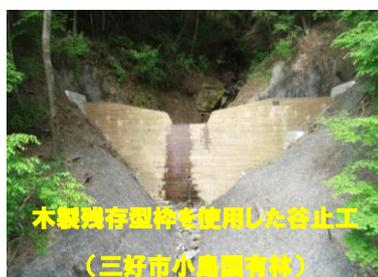
木製残存型枠を使用した谷止工
