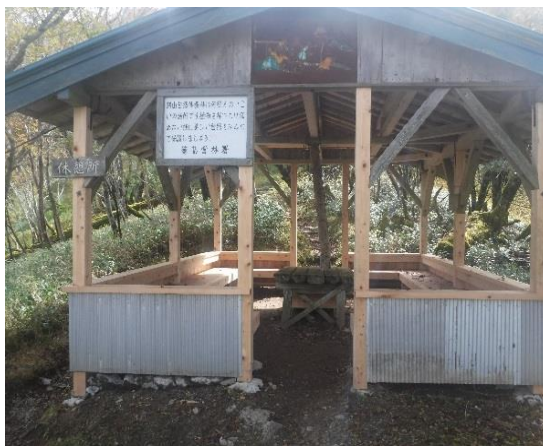
東屋(兼避難小屋)の整備 (H30年度整備)
