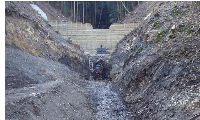
荒廃した溪流に設置された床固工(まんのう町柞ノ古林国有林)
