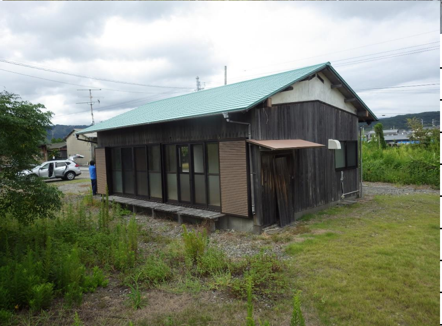
伊尾木東事業宿舎3内建物
