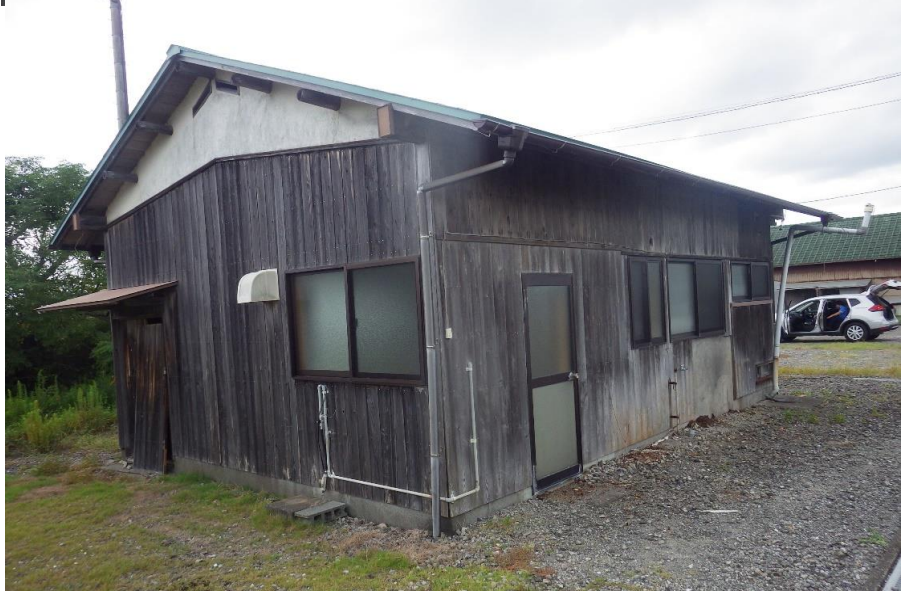
伊尾木東事業宿舎3内建物
