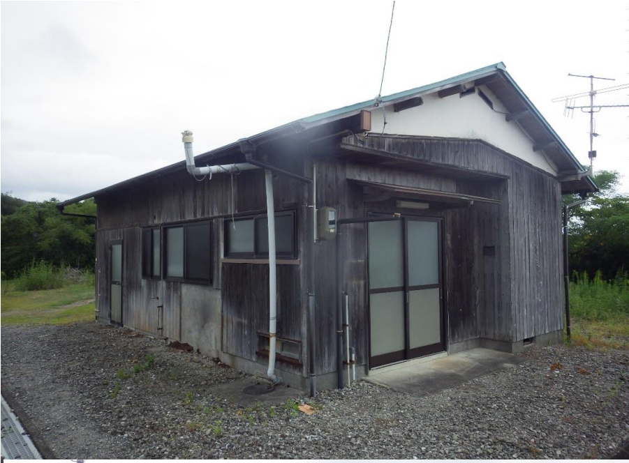
伊尾木東事業宿舎3内建物
